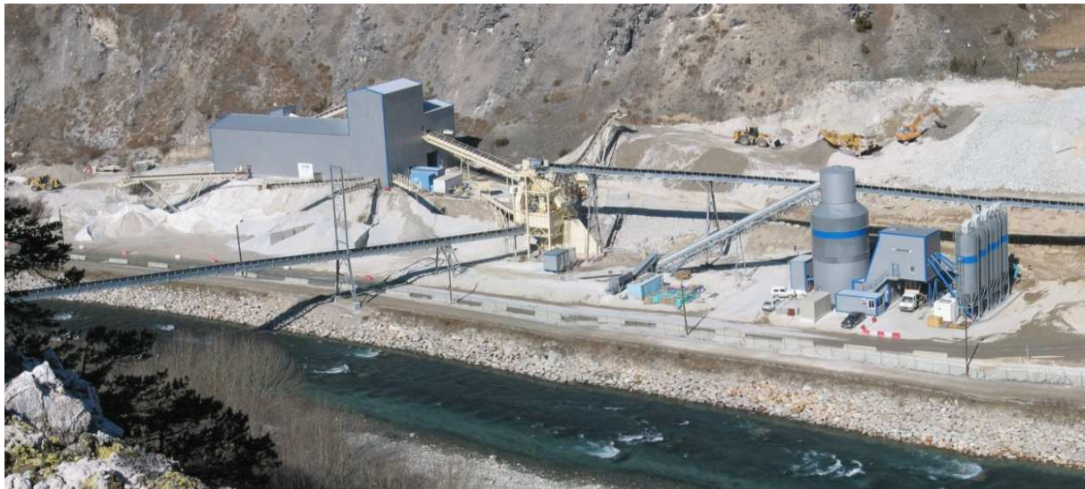
Figure 7. Station de traitement des matériaux de Modane, lors de l'excavation de la descenderie (2002)
