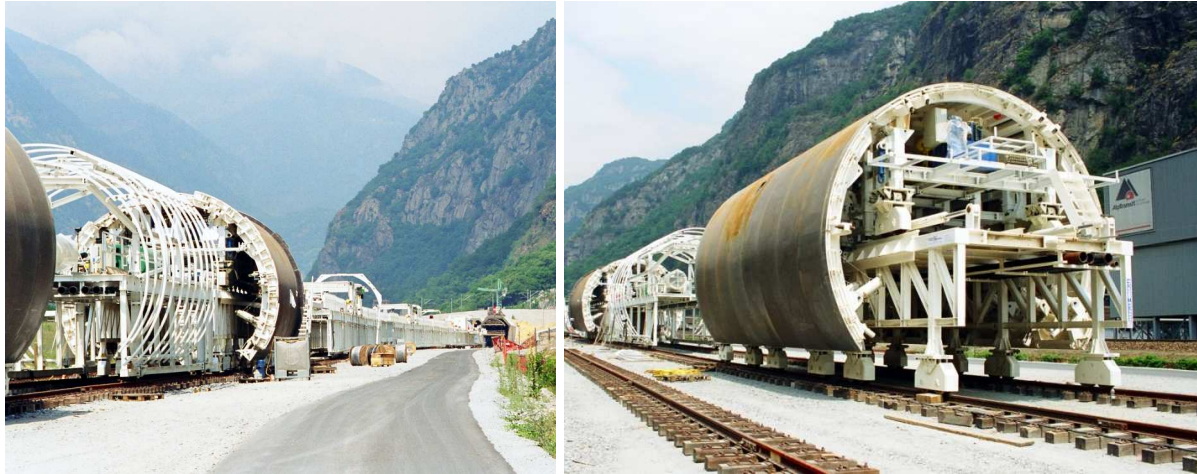
Figure 8. Dispositif Wurm du tunnel du Gotthard, lot Bodio Faido
