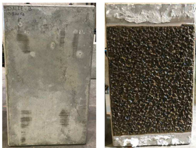
Figure 11. Face exposée au feu de la dalle B avant et après l'essai de sélection
