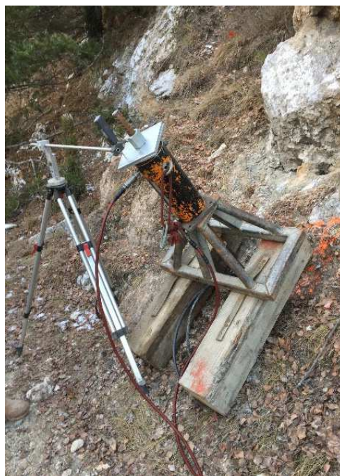
Figure 9. Secteur A4 – Tête Amont galerie - Dispositif d'un essai d'arrachement de clous
