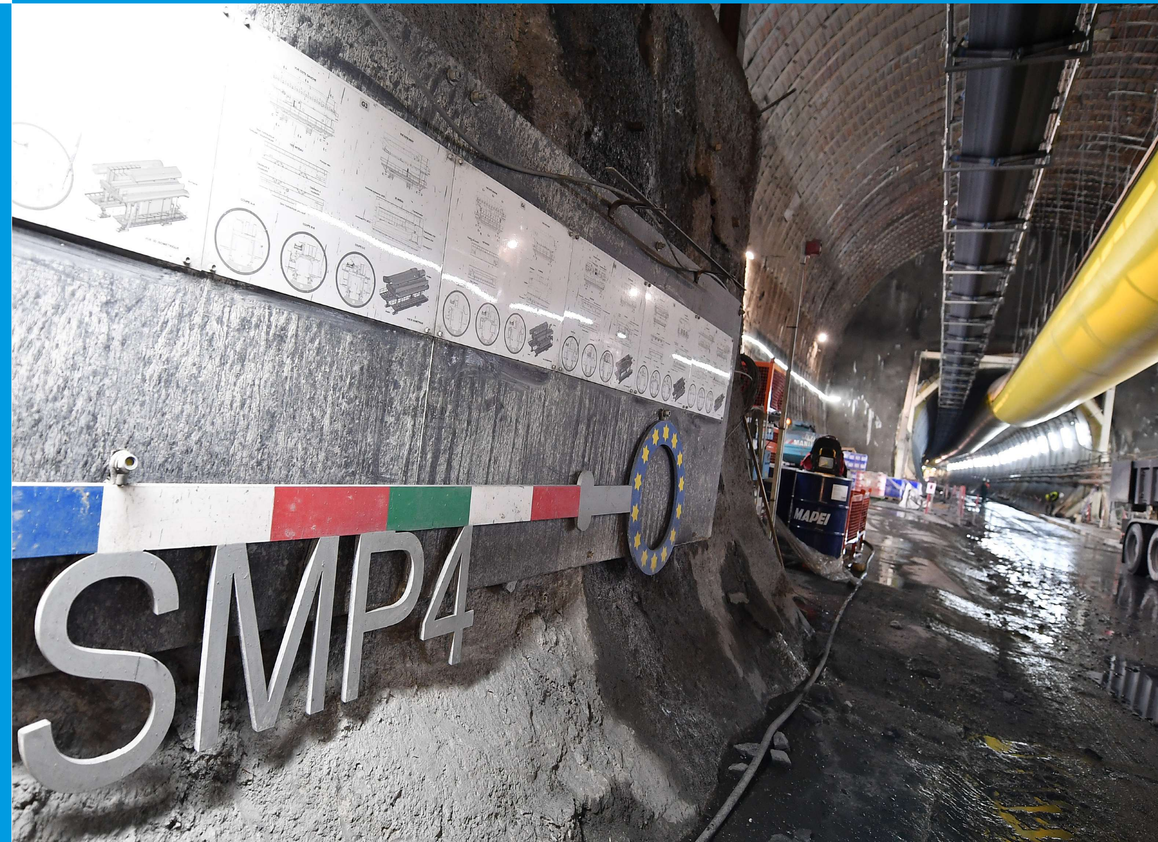
Il cantiere della Torino-Lione a Saint-Martin-la-Porte, in Francia, dove è in corso lo scavo di una galleria geognostica nell'asse e nel diametro del tunnel di base del Moncenisio
