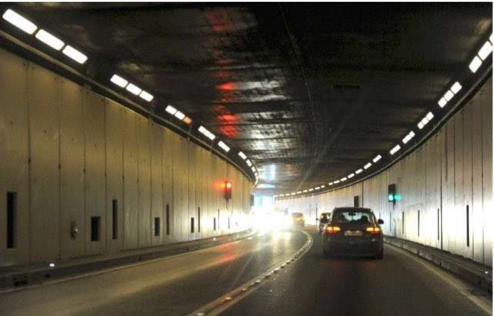
Galleria autostradale del Gottardo
