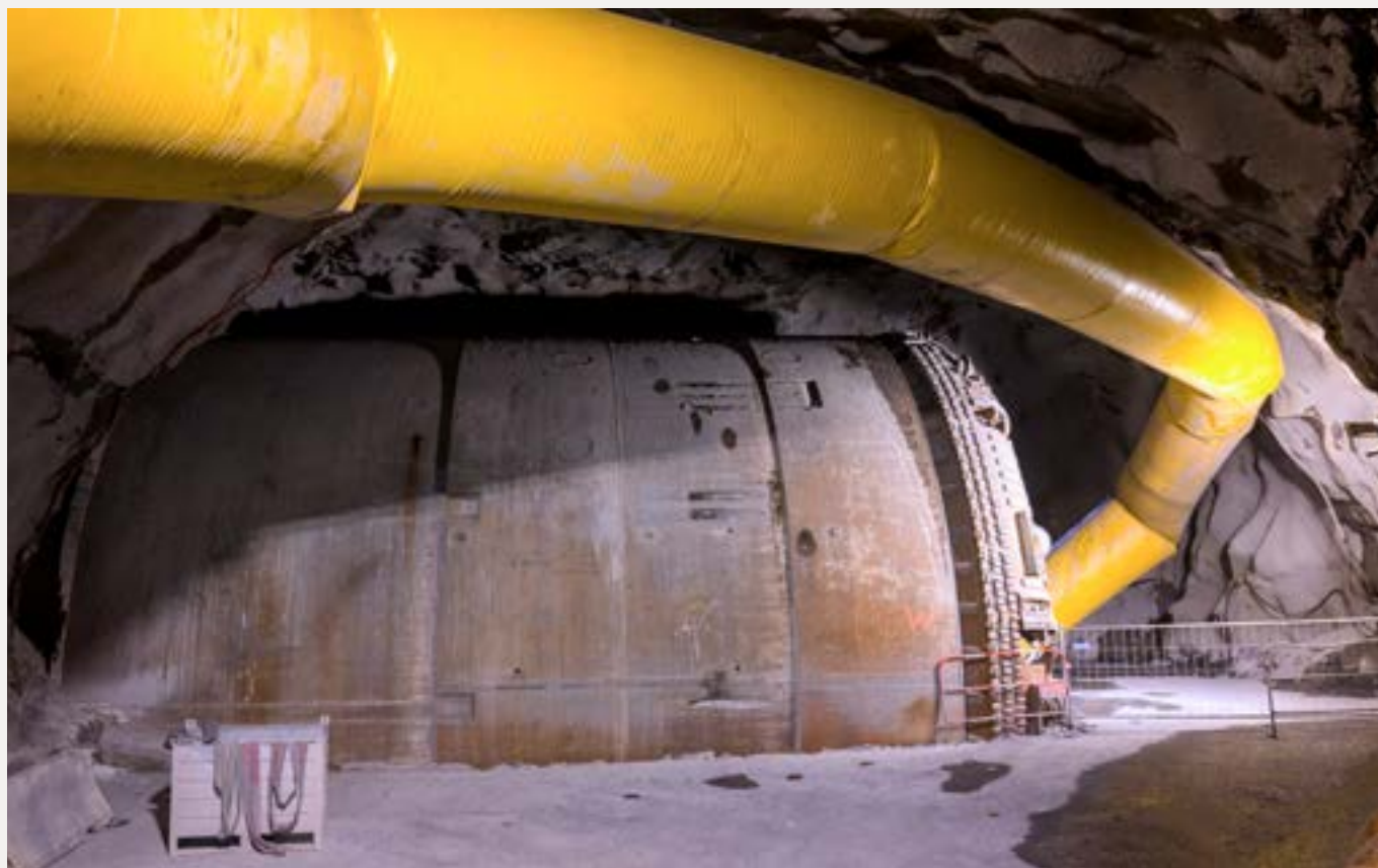
→ Saint-Martin-la-Porte, France / Le tunnelier Viviana lors de la première phase d'entretien
