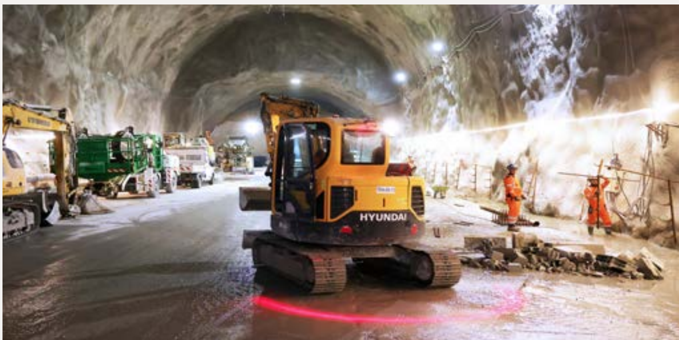
➔ Modane, France / Des engins à l'œuvre dans le tunnel, équipés de feux de signalisation afin de réduire le risque d'accident
