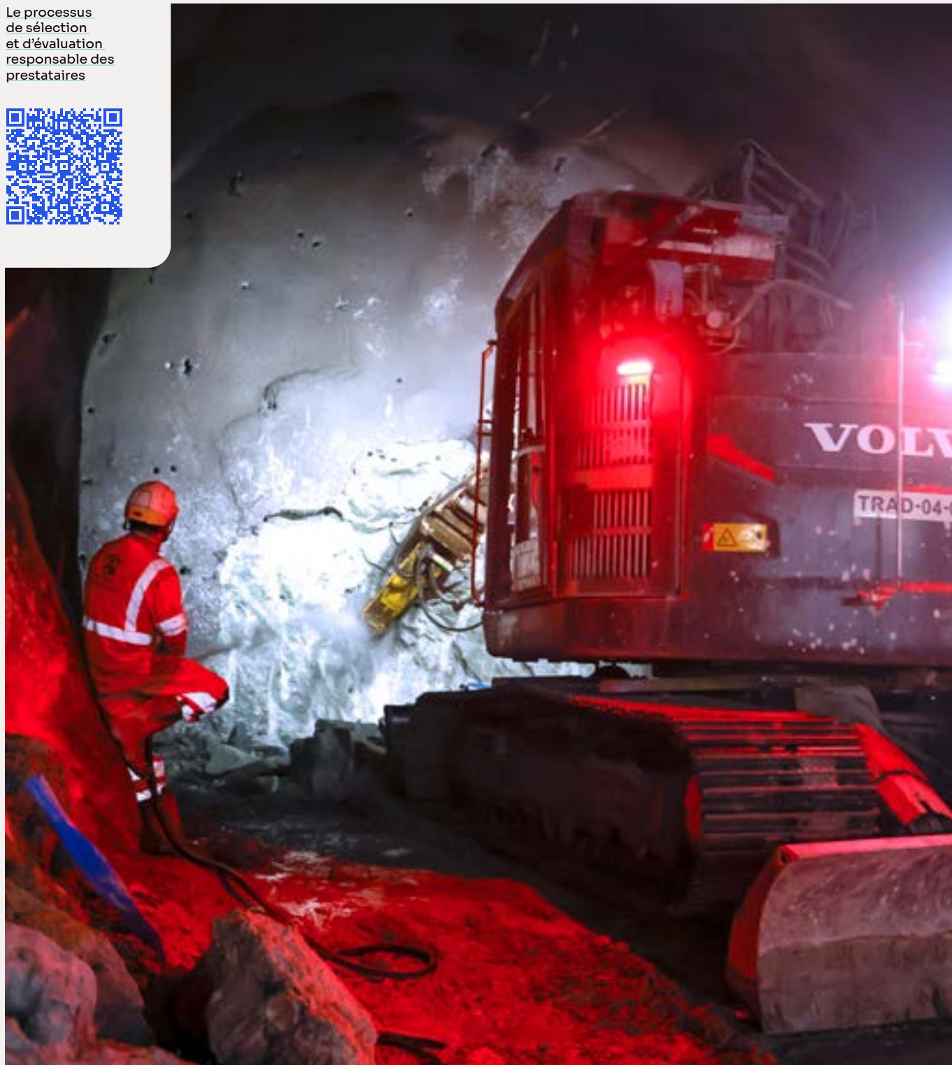
La Praz, France / Un ouvrier surveille les travaux d'excavation en méthode conventionnelle
