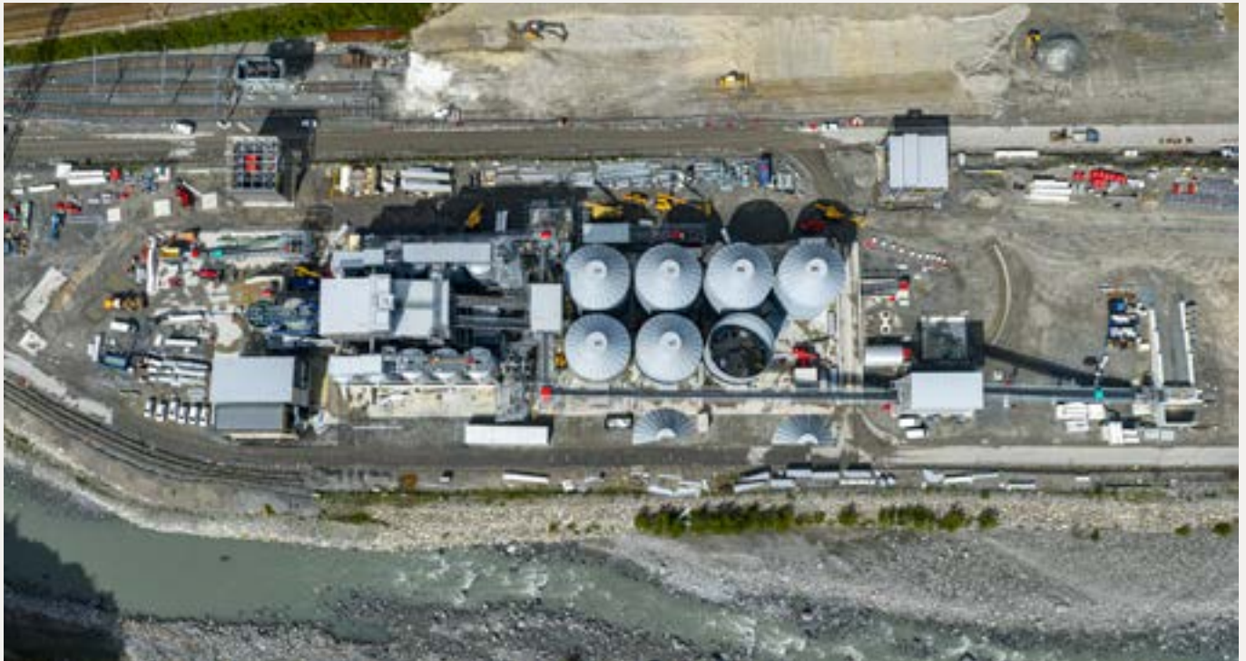
→ Saint-Julien-Montdenis, France / Station de valorisation des matériaux d'excavation à Illaz
