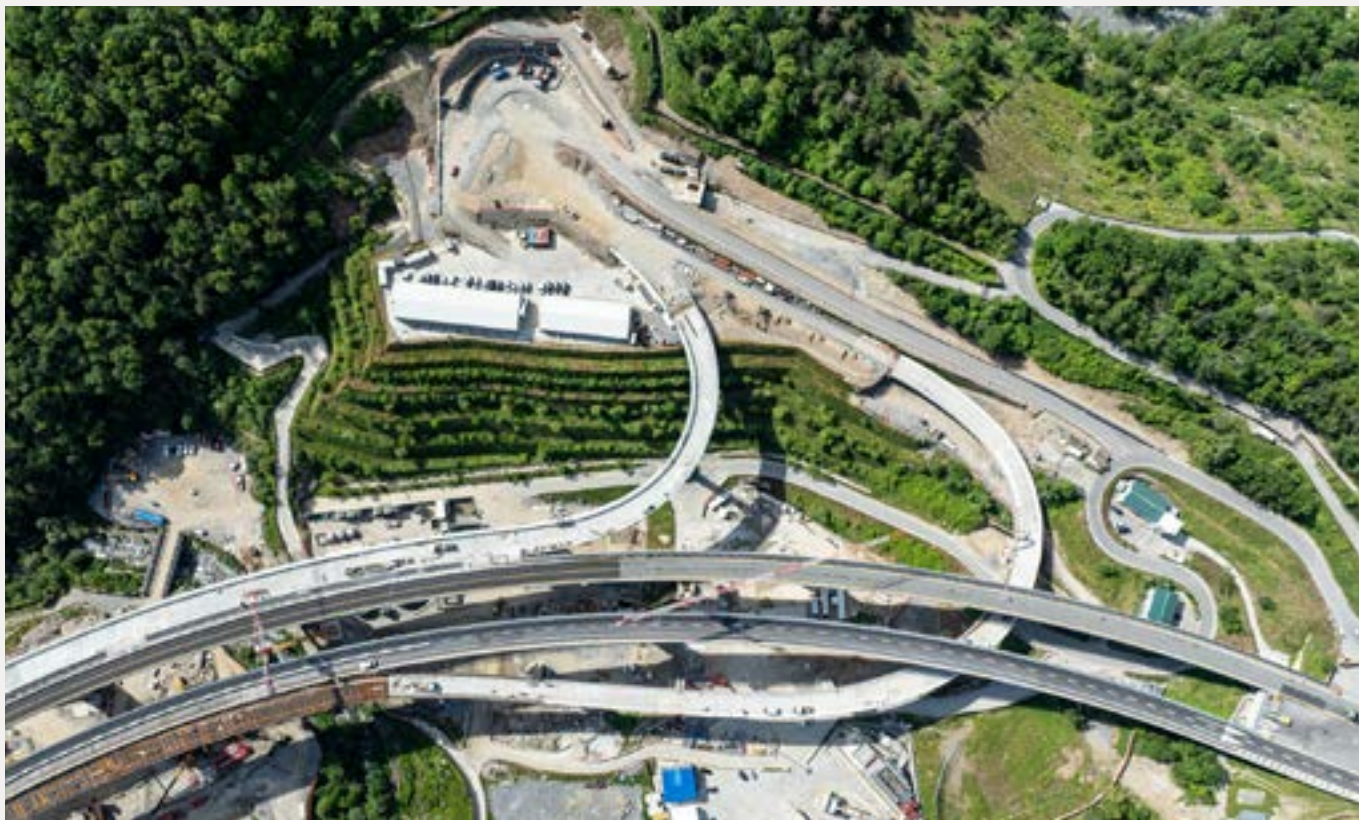
→ Chiomonte, Italie / Vue aérienne du chantier CO03/04 avec le nouvel échangeur autoroutier
