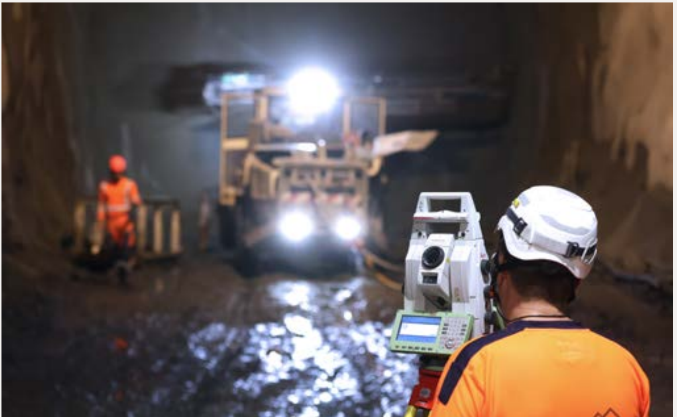
→ Saint-Julien-Mont-Denis, France / Mesures souterraines réalisées au cours des excavations en méthode conventionnelle
