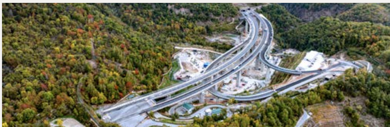
→ Chiomonte, Italie / Vue aérienne du chantier CO03/04 avec le nouvel échangeur autoroutier
